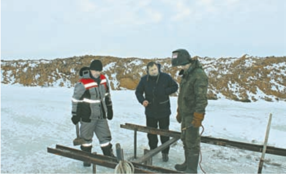
Обустройство водоема. В центре – Алексей Крысь.
