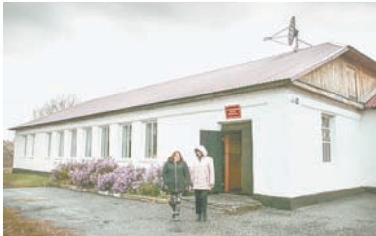
Поселковый Дом культуры отремонтирован на фермерские деньги.
