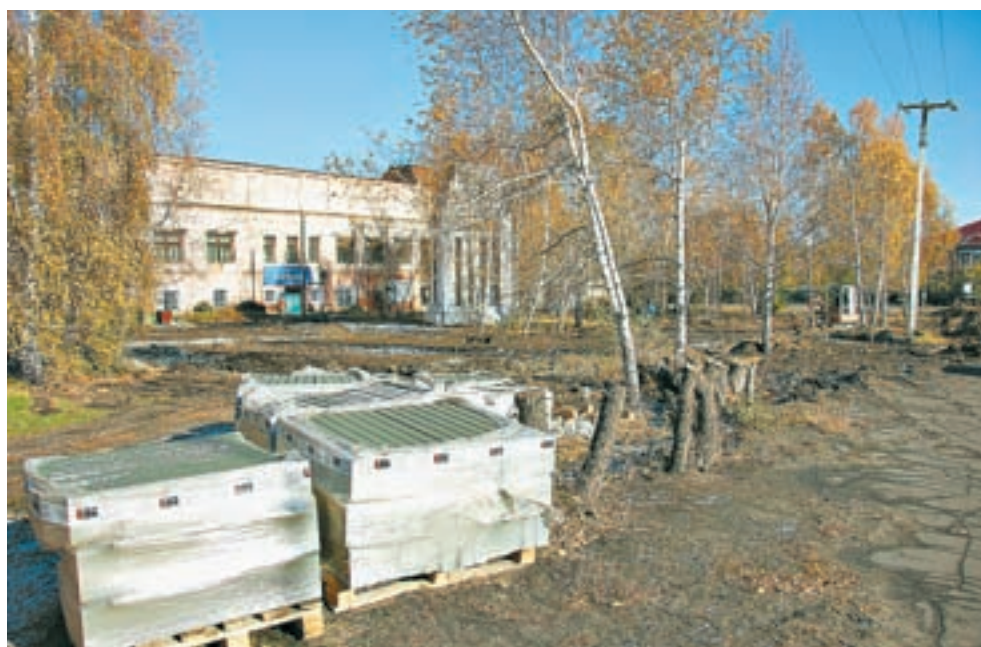
Активные ремонтные работы ведутся в рамках проекта «Комфортная городская среда».
