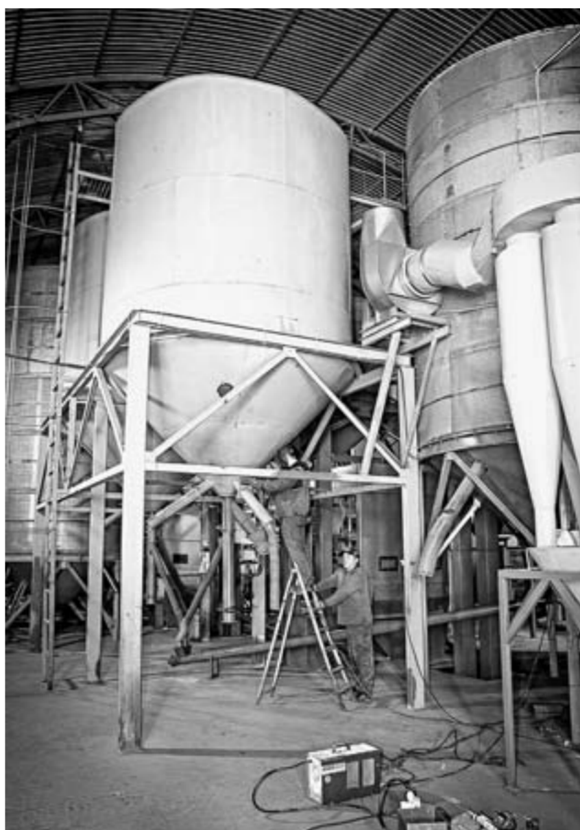
Идет монтаж оборудования.
