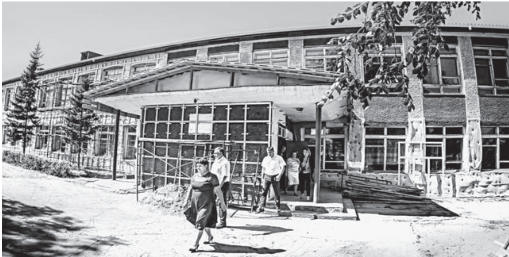
В школе села Киприно Шелаболихинского района проходит большой ремонт.
