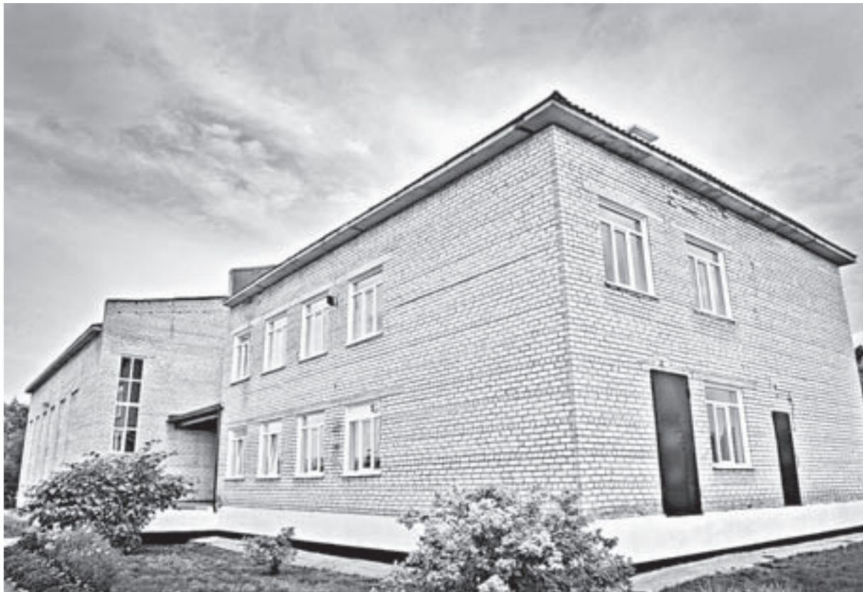
Крупный ремонт в образовательном учреждении – поручение президента.
