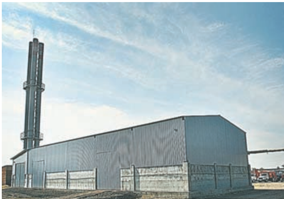
Новая современная котельная заменит пять старых.
