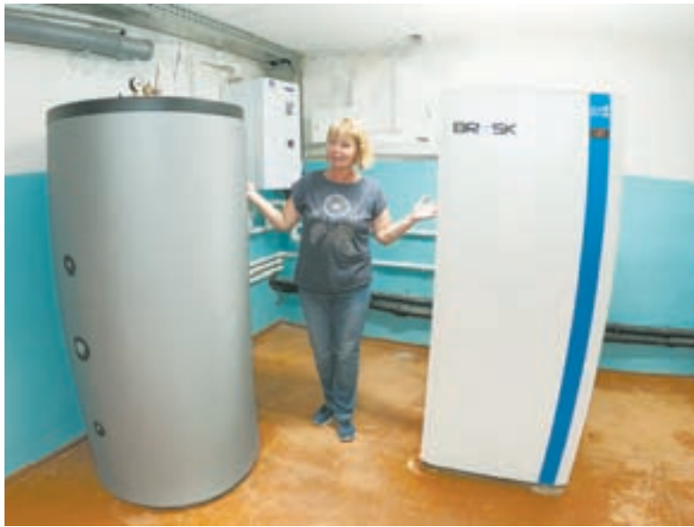
По правую руку от Ольги Грениной расширительный бак, по левую – компрессор.
