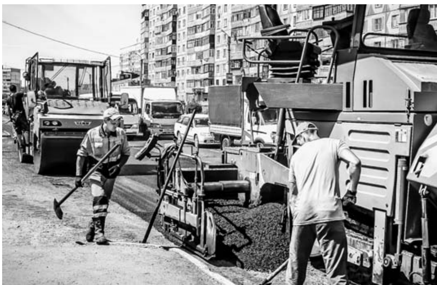
На ремонт дорог в Бийске дополнительно выделено еще 80 млн рублей.
