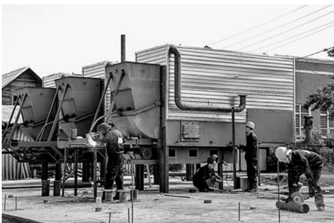
Идет монтаж оборудования.
