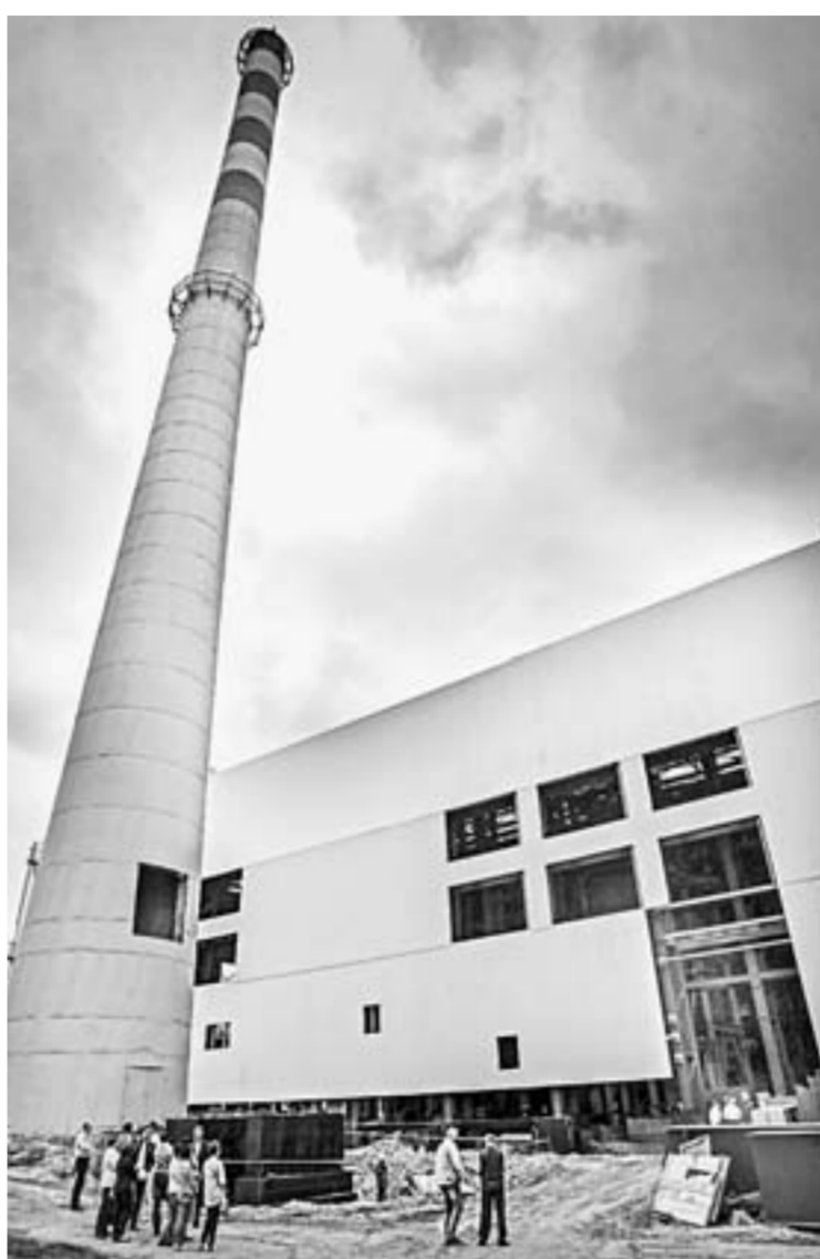
Строительство цеха завершится через 14 месяцев.
