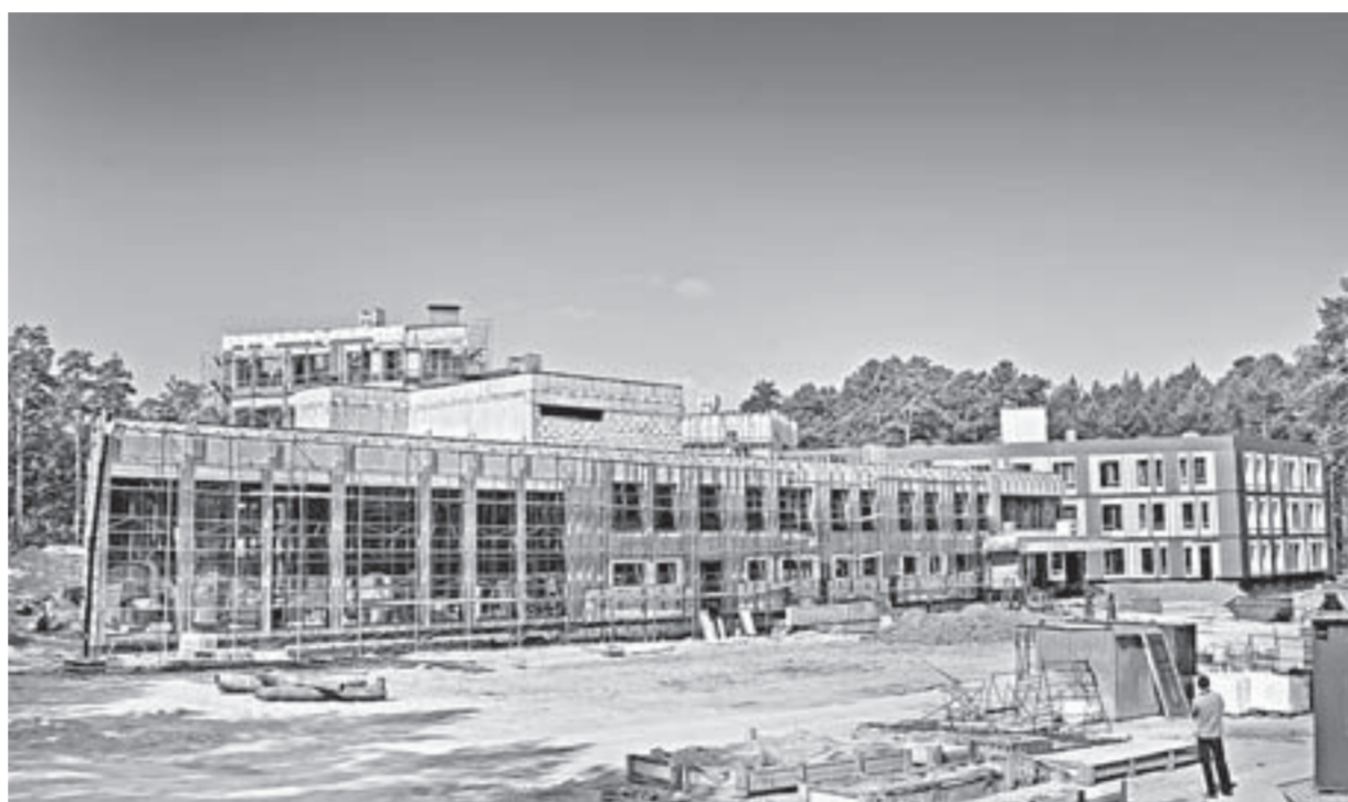
Центр практически построен. Остались отделочные работы.
