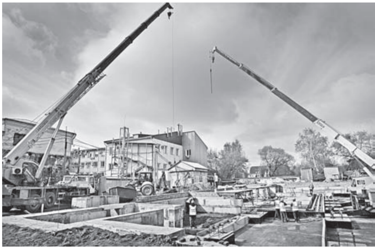
Театр кукол: строительство в разгаре.
