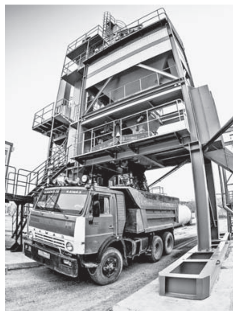
Как минимум 10 танк НамАЗов за час обеспечит асфальтобетонной смесью этот заводик.
