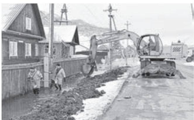
Работа по устранению последствий паводка.
