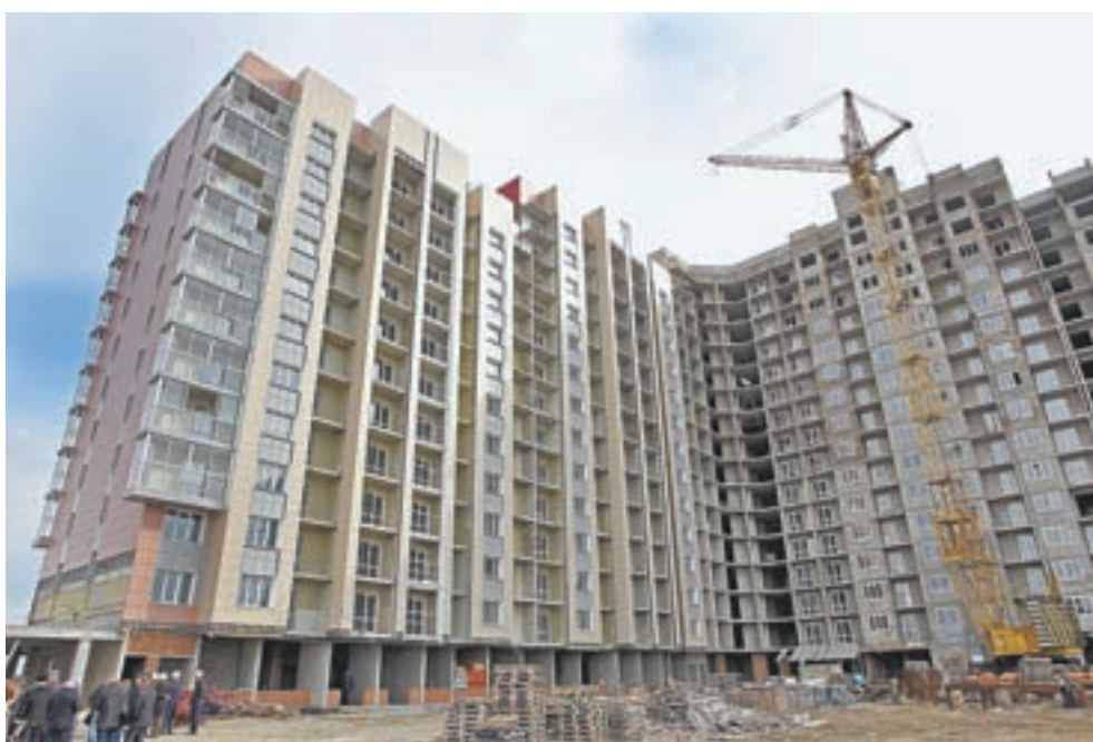
На площадке комплекса идут работы.
