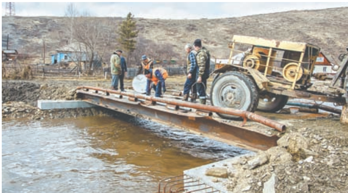
Работы по устранению последствий паводка в Солонешенском районе.
