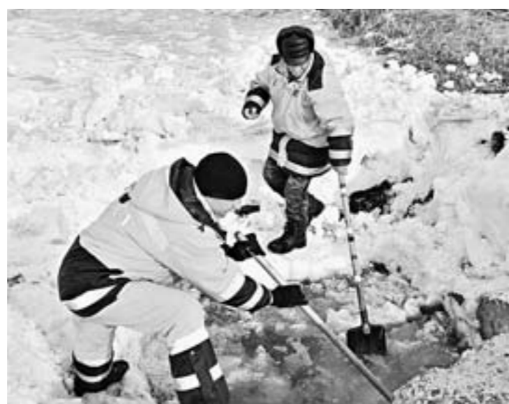
Очистка водопропускных труб.
