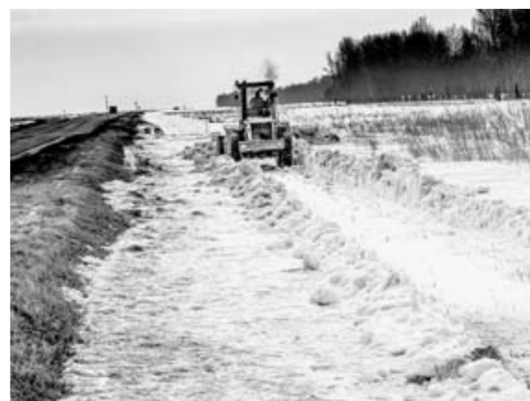
В крае очищены подводящие русла к водопропускным сооружениям.
