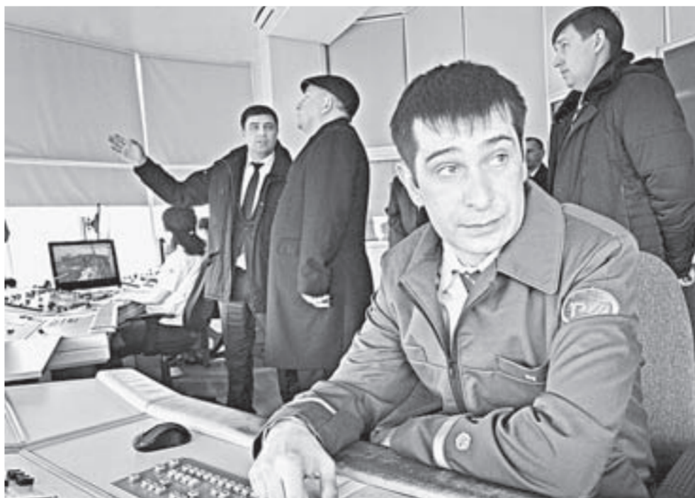
Пульт управления станции Алтайская.
