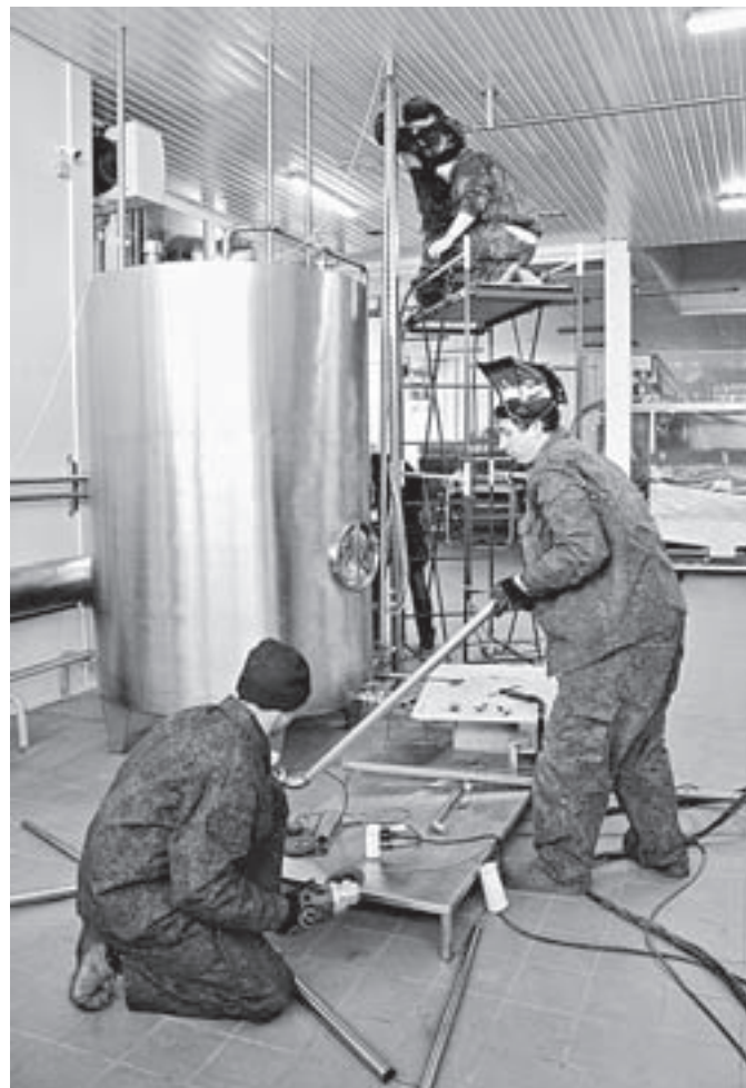
Рабочие заканчивают монтаж оборудования.
