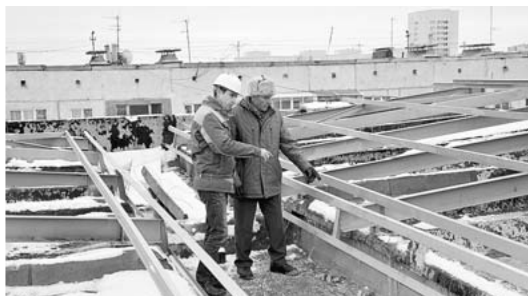
Строители объясняют жильцам преимущества металлической крыши перед деревянной.
