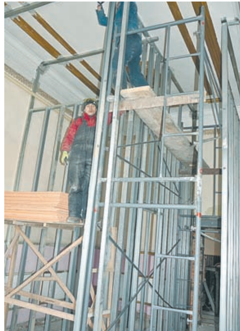
На первом этаже кипит работа.
