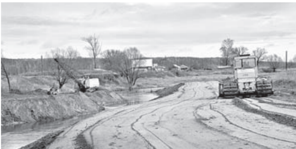
Мощная техника используется на расчистке русел рек и строительстве защитных дамб.
