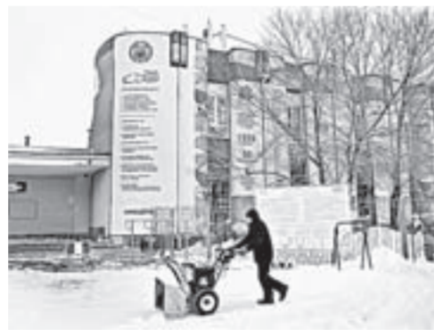
Здание ждет ремонта.
