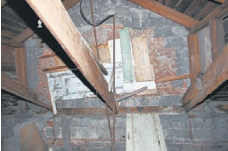
Через забитое слуховое окно дождь все равно просачивается.
