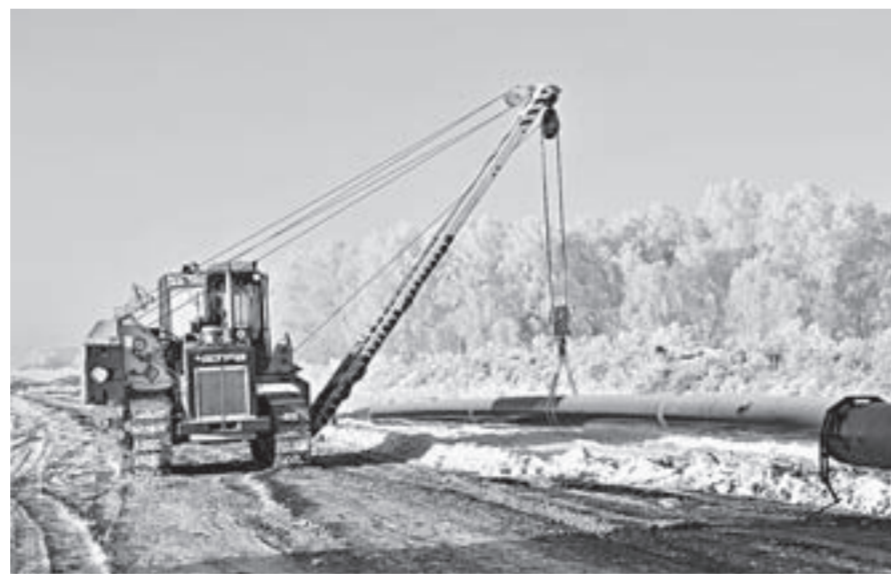
Проложены первые десять километров газопровода.
