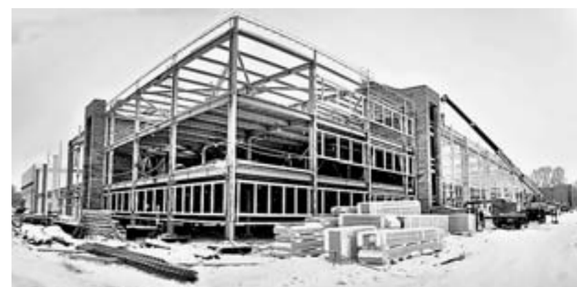
Возведение завода «Русская кожа – Алтай» должно завершиться в конце 2018 года.
