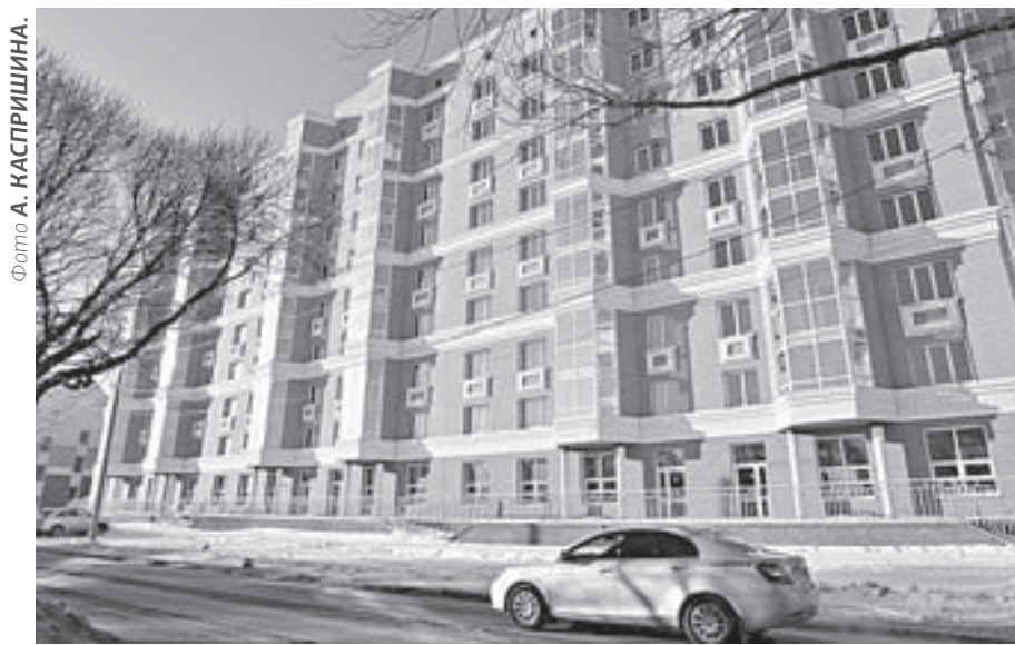
Новые дома – новая ответственность застройщика и дольщиков.
