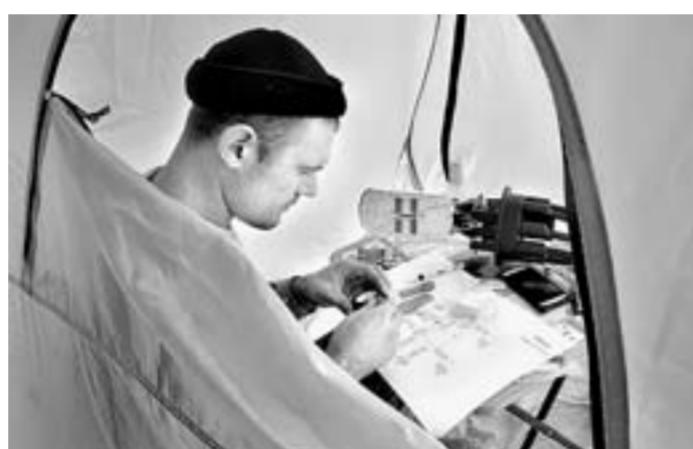
Сварка оптических волокон – один из этапов строительства сети будущего.
