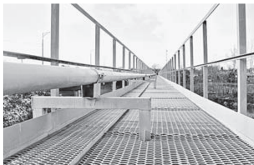
Чтобы протянуть газопровод через реку, пришлось строить эстакаду.
