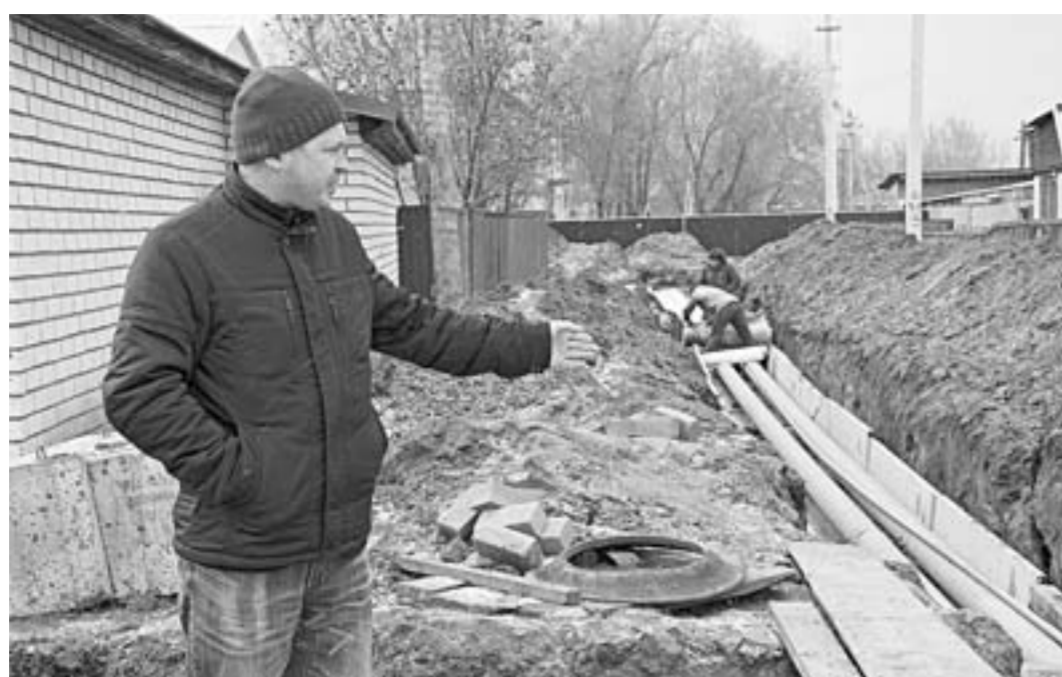
Дмитрий Емельянов демонстрирует готовность теплотрассы к зиме. Последний её отрезок одевают в полимерную изоляцию.
