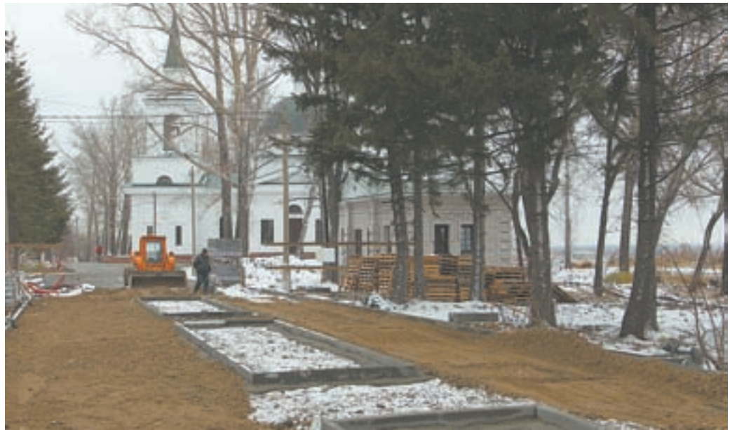
Идет реконструкция территории Нагорного парка.
