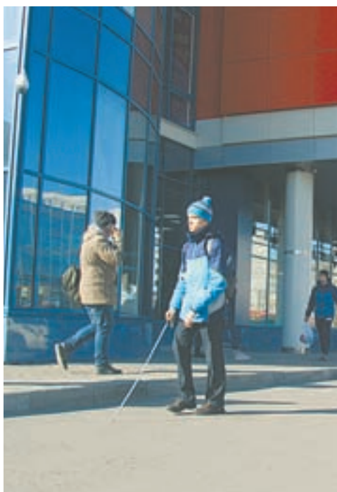
Необозначенная рифленым маркером ступень стала серьезным препятствием.
