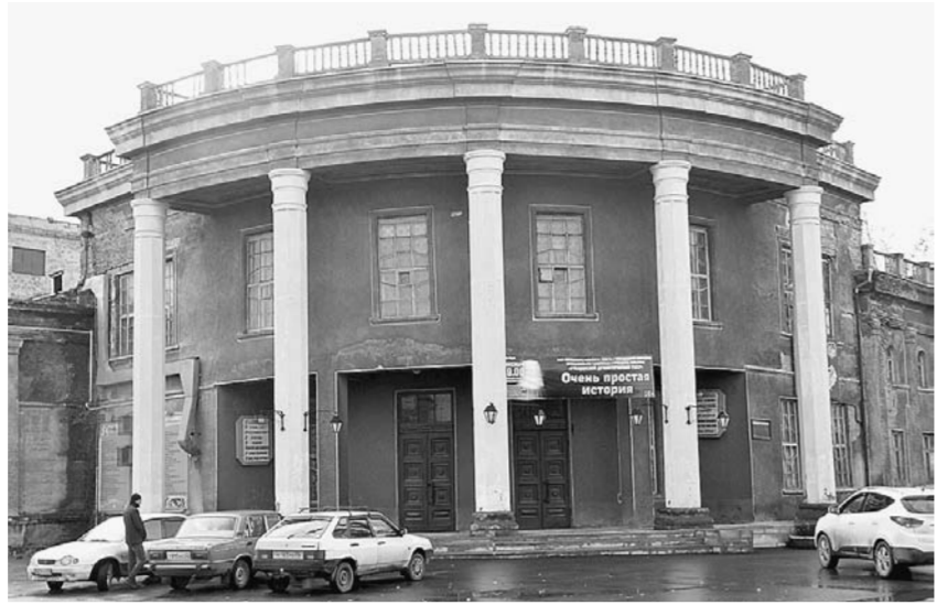
Здание драматического театра дождалось ремонта.
