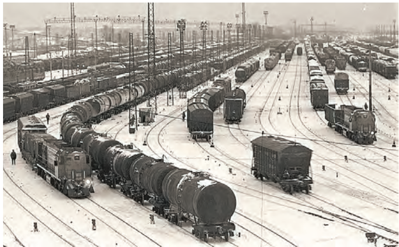
Формирование составов на железнодорожной станции Алтайская. В статье «Грузопоток нарастает» автор рассказывает о строительстве на железнодорожной станции Алтайская крупнейшего в Сибири поста централизованного управления, внедрения ЭВМ и автоматики, модернизации парка тепловозов и электровозов. Железнодорожники Алтайской трижды завоевывали переходящее Красное знамя МПС страны.
