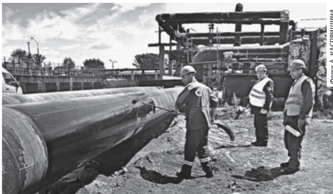
На протяжении всего лета в Рубцовске шла масштабная работа по модернизации теплоэнергетического комплекса.
