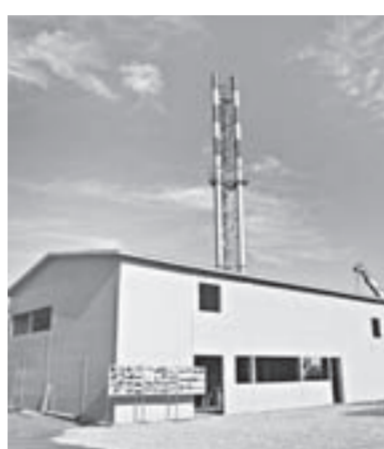
Строится новая котельная.
