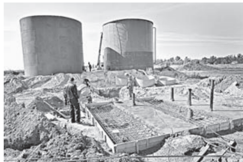
Танки крупных работ на объектах водоснабжения в крае не проводились еще никогда.
