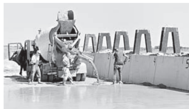
Новая силосная яма.
