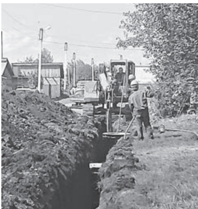
Начало строительства водопровода на Старом Балиндере.
