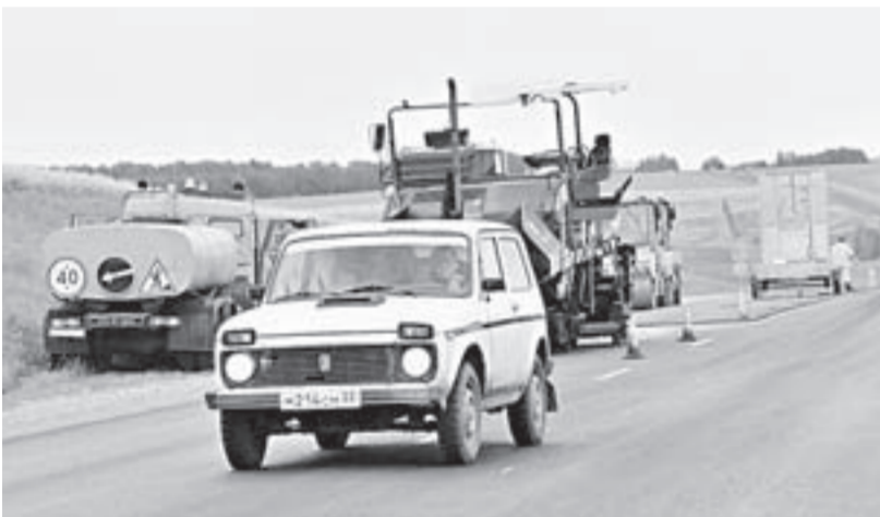
Ремонт асфальтобетона по технологии «Новачип».
