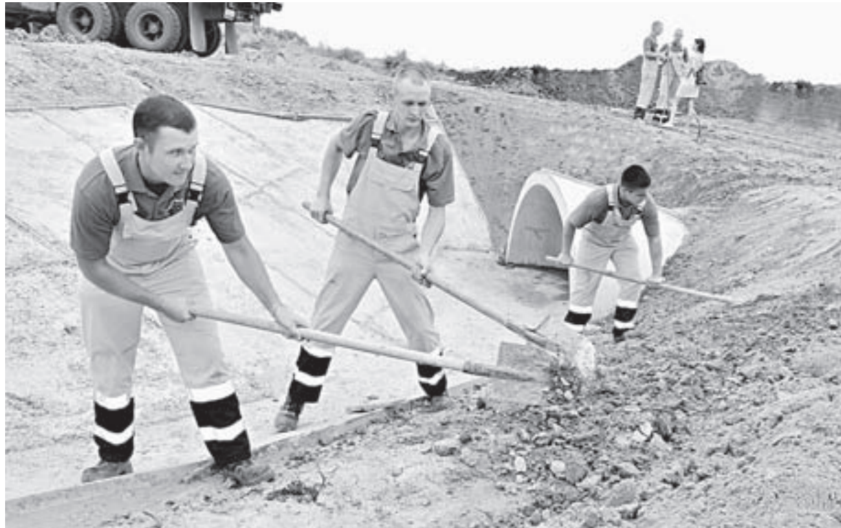
Стройотрядовцы выравняют землю возле забетонированного ими бордюра.
