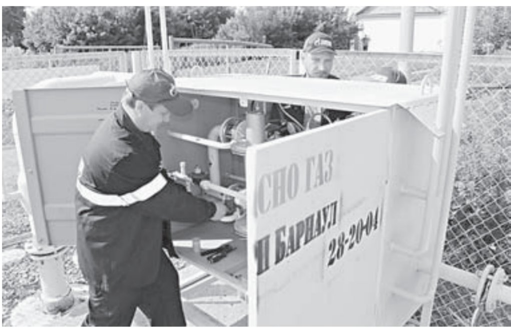
Монтажники проводят регулировку оборудования.
