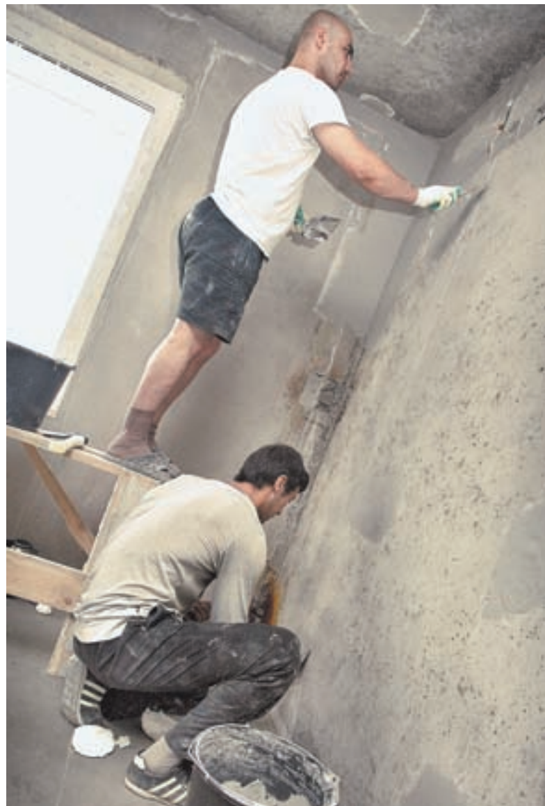
В квартирах ведутся отделочные работы.
