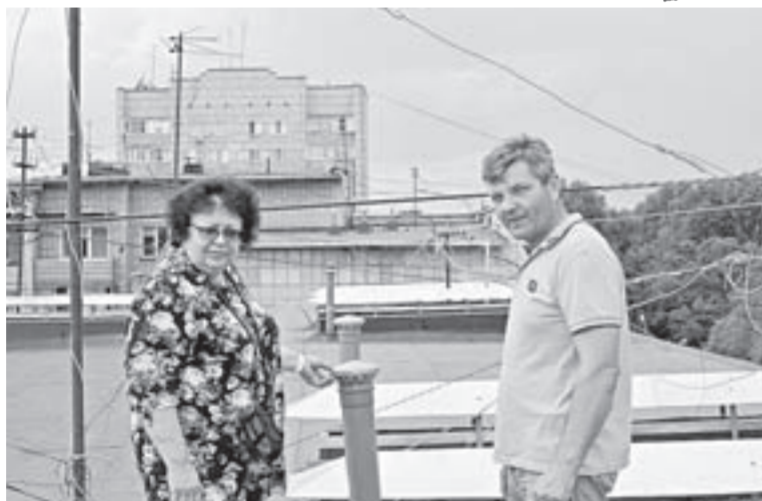
Комиссия поднялась на крышу, чтобы оценить качество ремонта.
