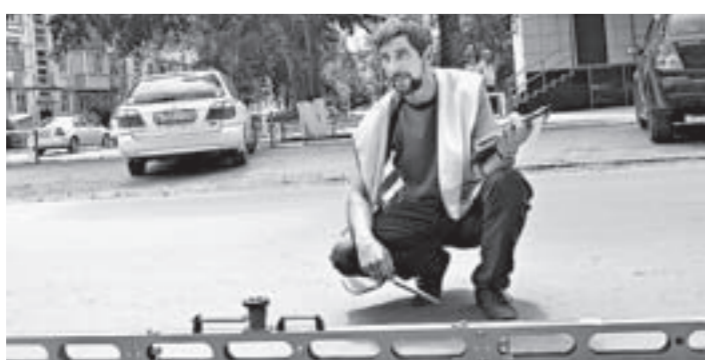
Евгений Махров проверяет ровность асфальта на ул. Северной.
