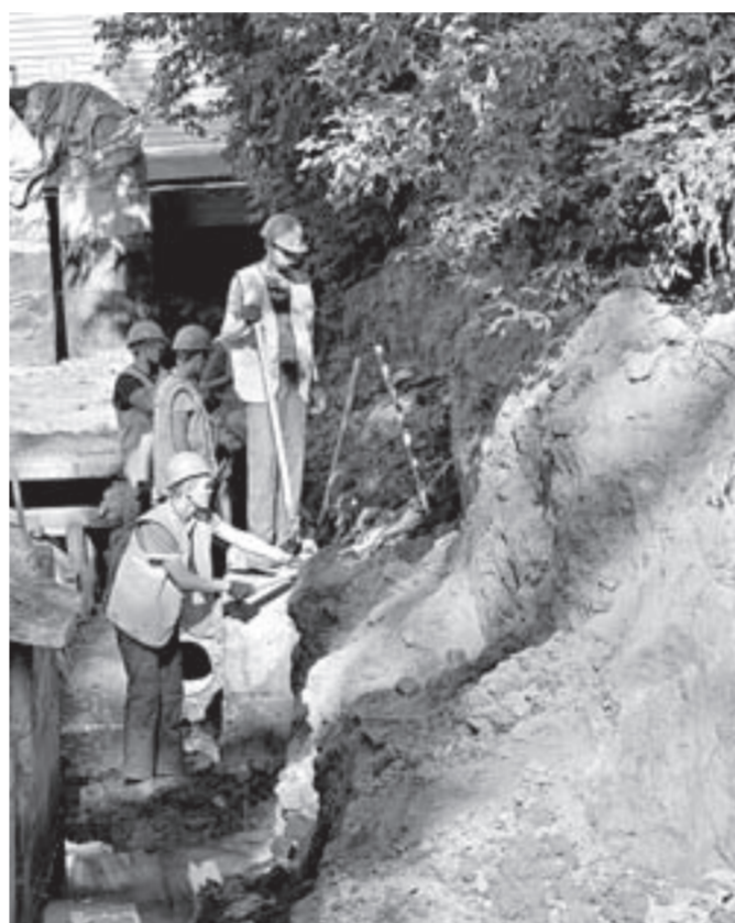
Стройотрядовцы заняты на укладке труб.
