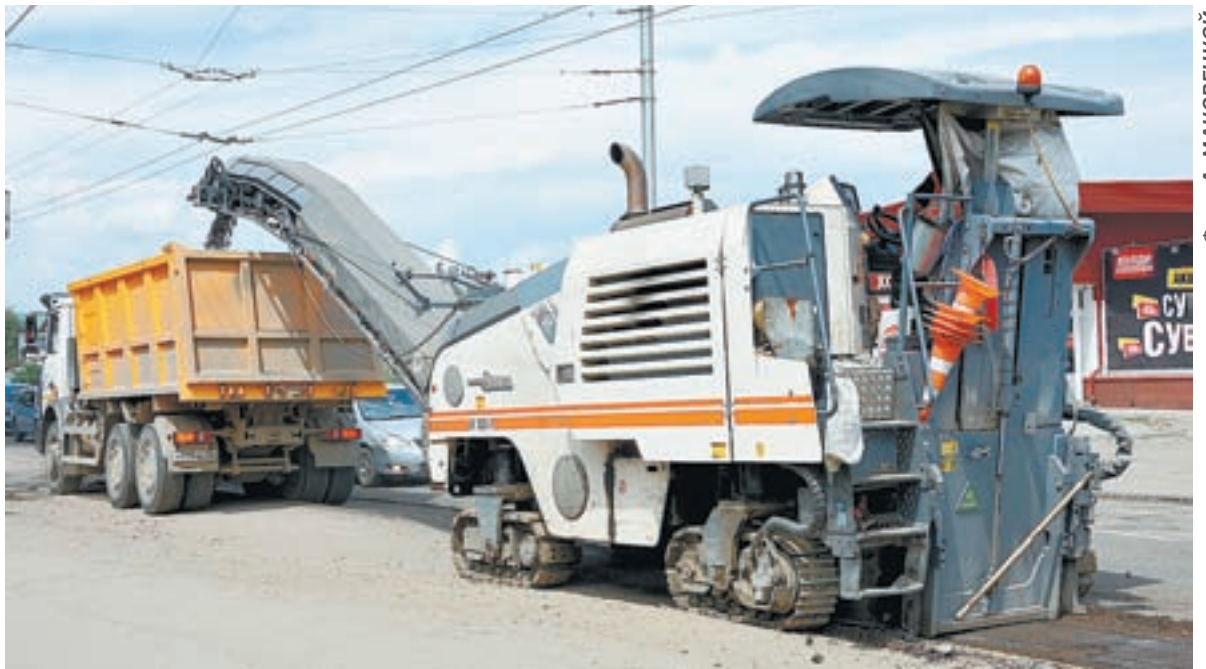
Обновление дорожного полотна в Рубцовске.
