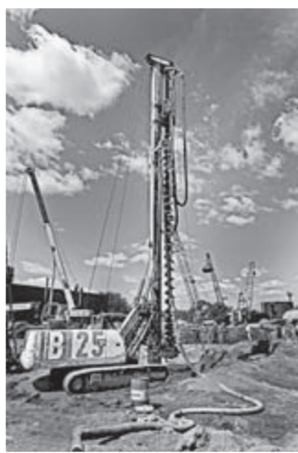
Буровая установка закладывает сваи.
