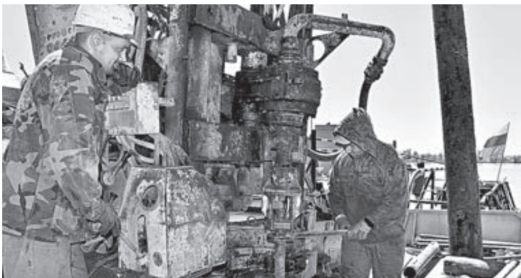
Сваи вбивают на глубину 50 м.
