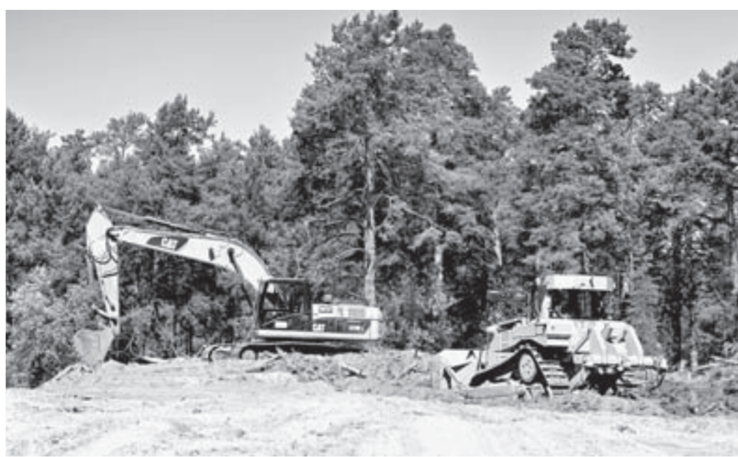
Сейчас на площадке готовятся рыть котлован.
