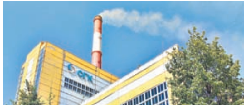
На ТЭЦ-3 начался капитальный ремонт.
