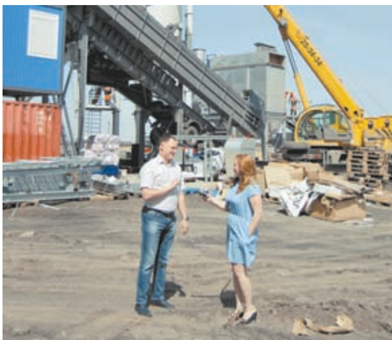
Новый модульный асфальтобетонный завод установлен в Камне-на-Оби.
