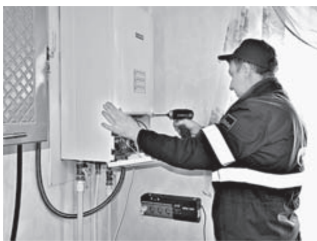
Идет настройка газового котла.
