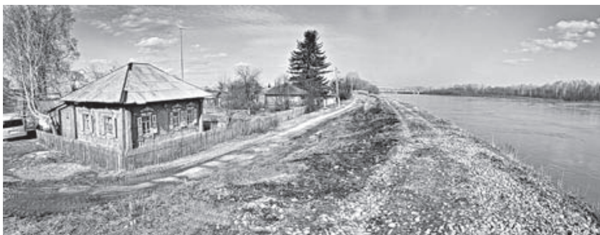
Гидротехническое сооружение спасает Тальменку от большой воды.
