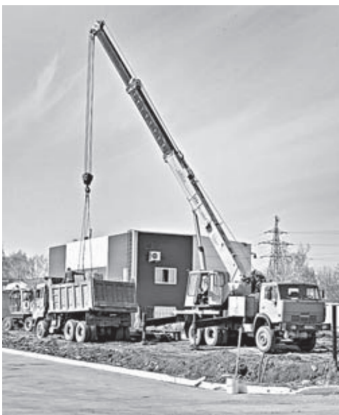
Строительство цеха по производству маргарина началось.
