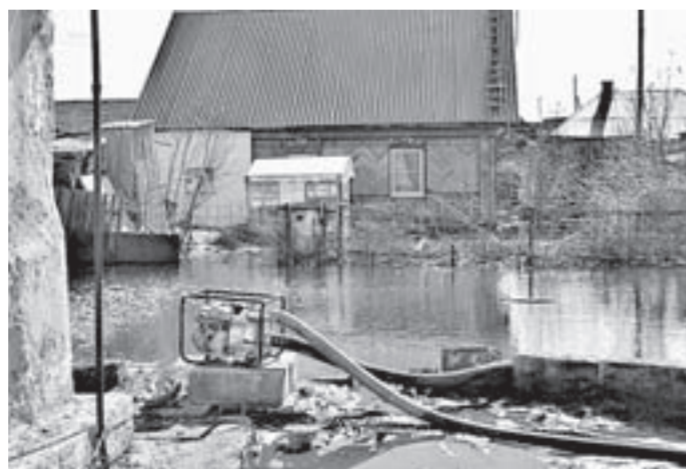
Силами МЧС проводится откачка воды.
