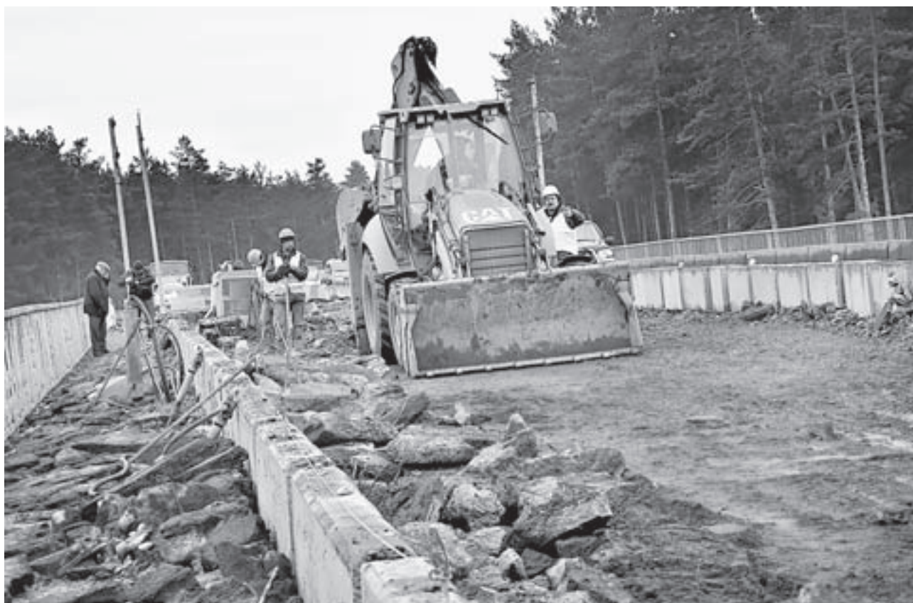
Сейчас дорожники снимают верхний слой покрытия.
